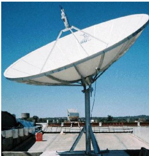
Figura 38 Antena Satelital Banda C
