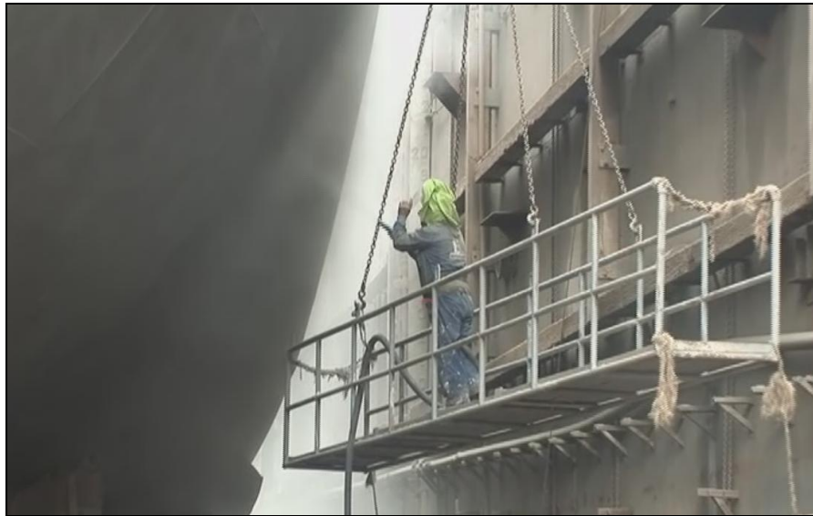
FIGURA 20: SANDBLASTING DEL CASCO
