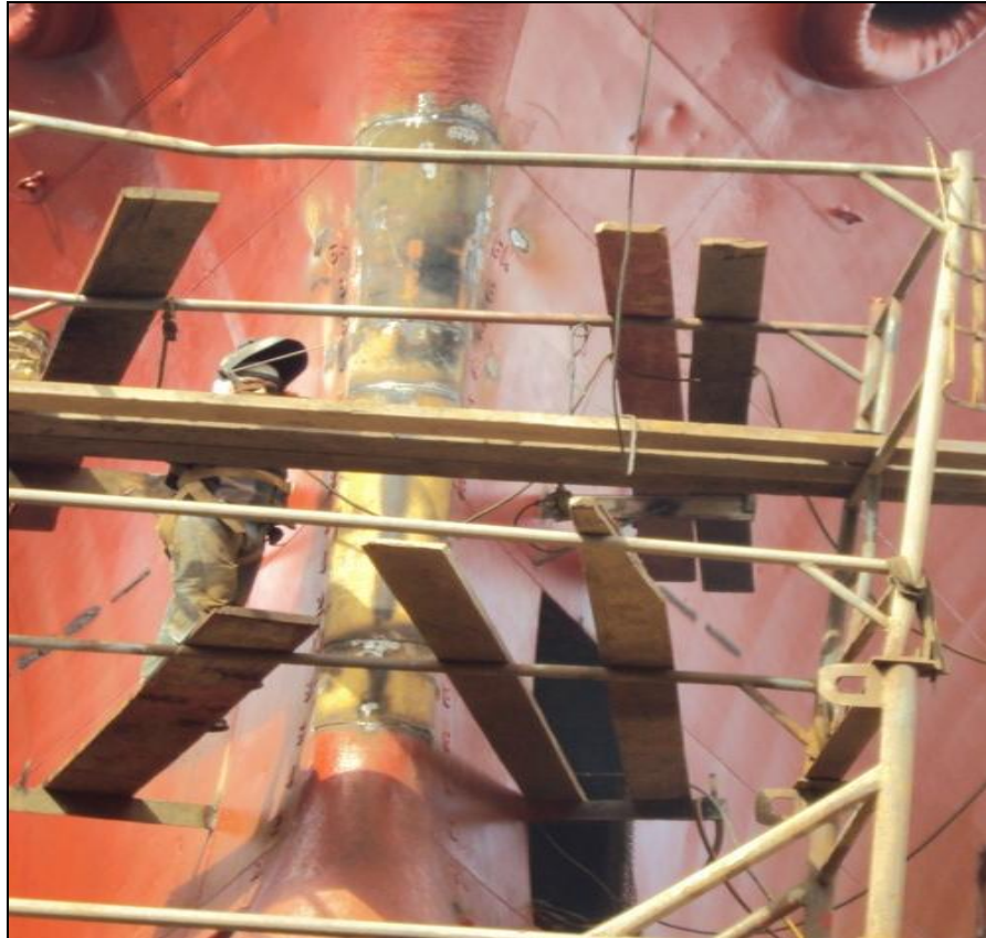
FIGURA 13: SOLDADURA DE PLANCHAJE POR ALTO
