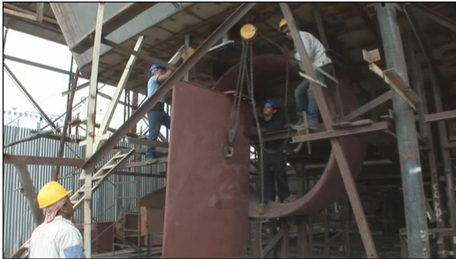
FIGURA 15: DESMONTAJE DEL SISTEMA DE GOBIERNO
