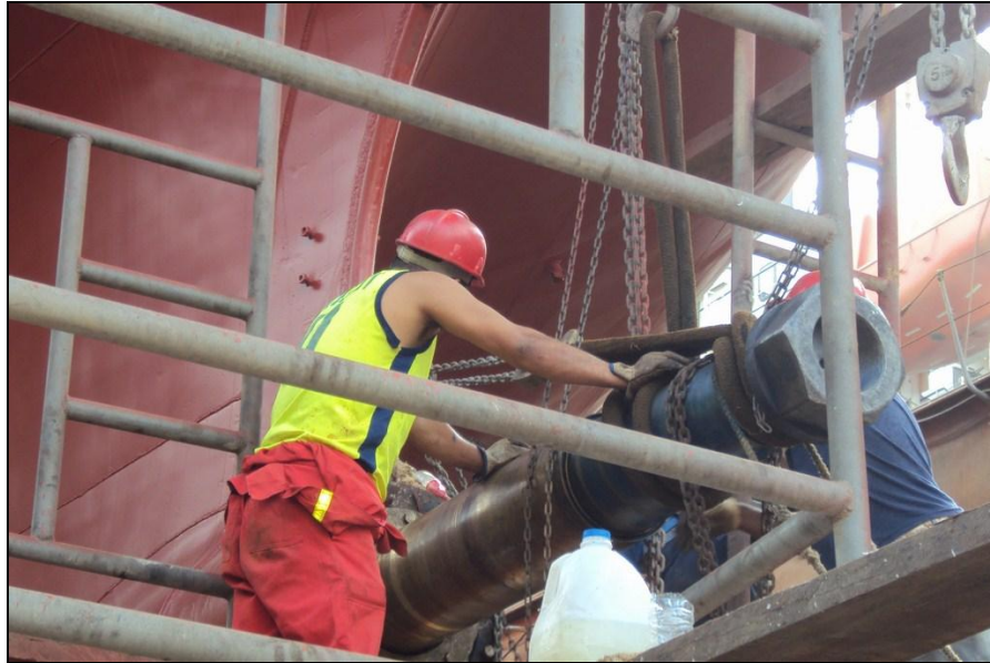
FIGURA 17: MONTAJE SISTEMA PROPULSOR
