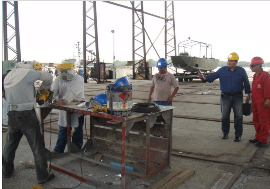
FIGURA 28: TRABAJOS DE GASFITERÍA
