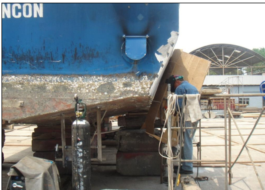
FIGURA 10: CEPILLANDO CORDÓN DE SOLDADURA
