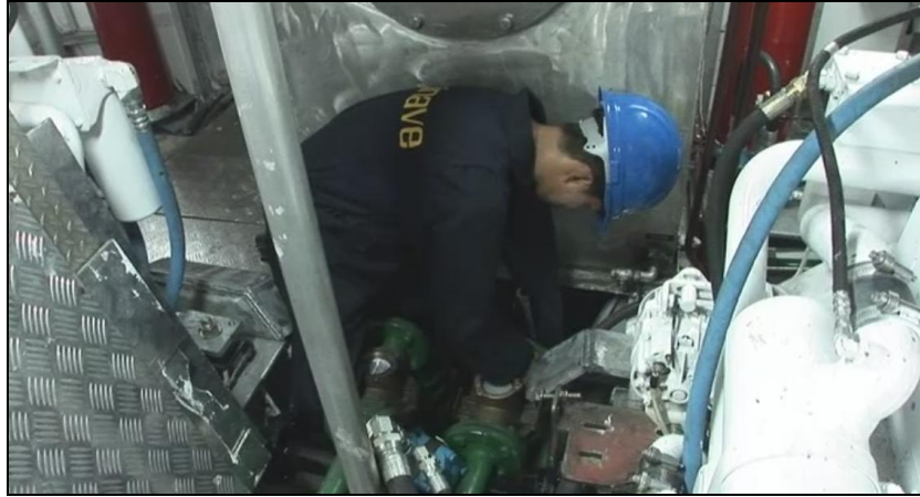
FIGURA 25: TRABAJOS EN VÁLVULAS
