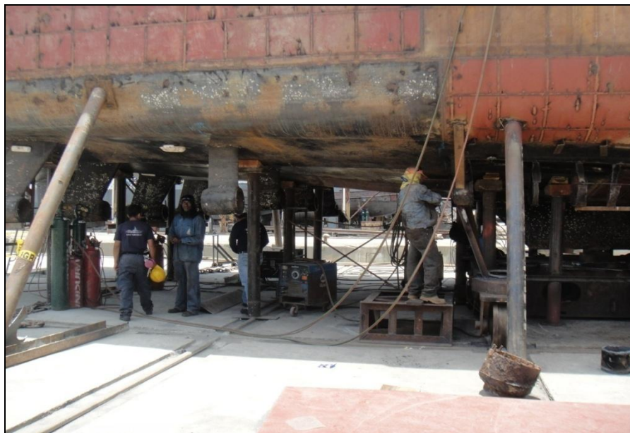
FIGURA 24: DESMONTAJE DE REJILLAS
