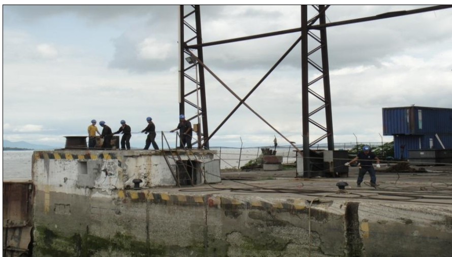
FIGURA 6: TRABAJOS EN CABLES DE AMARRE
