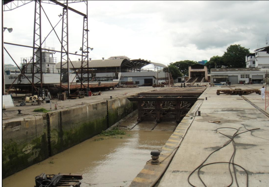
FIGURA 1: PREPARACIÓN DE PARRILLA DE VARAMIENTO
