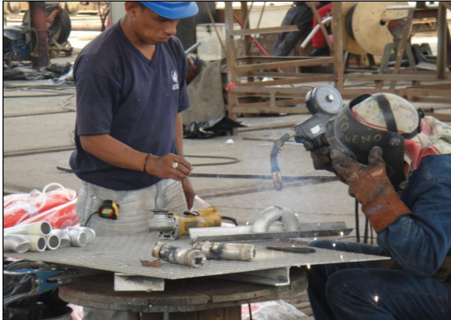
FIGURA 26 ENSAMBLAJE DE TUBERIAS
