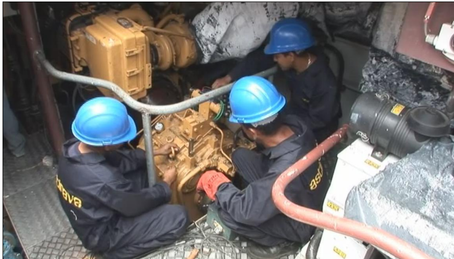
FIGURA 42: TRABAJOS EN MOTOR DE COMBUSTIÓN INTERNA
