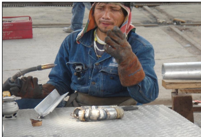
FIGURA 27 SOLDADURA DE TUBOS DE GASFITERÍA
