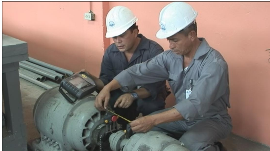
FIGURA 44: TRABAJOS EN MOTORES ELÉCTRICOS
