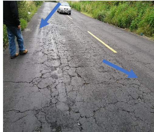
No existen marcas sobresalidas de pavimento (tachas)
