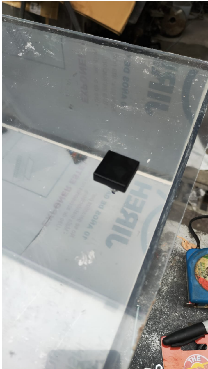
Figura 34. Instalación de manigueta en puerta abatible.[81]
