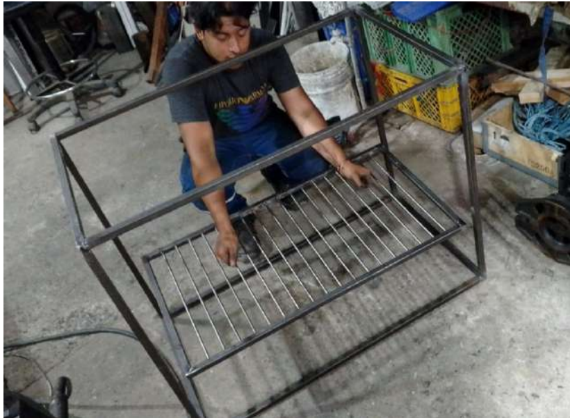
Figura 25. Fabricación del armazón metálico y colocación de la rejilla de soporte del contenedor de cultivo. Fuente: Los Autores.
