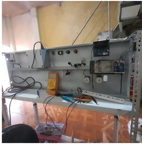
Figura 24. Proceso de integración eléctrica.
