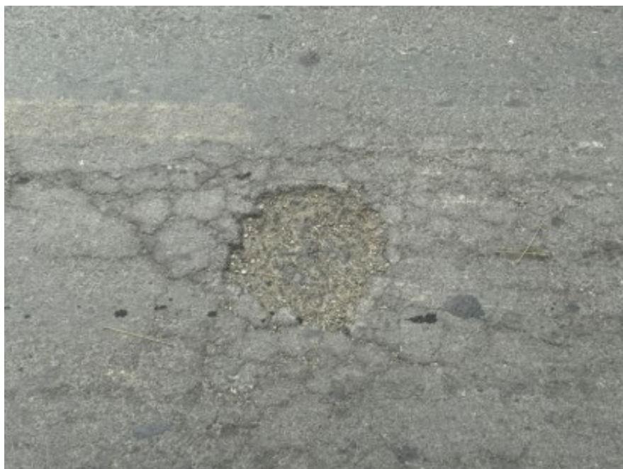
ILUSTRACIÓN 151: FALLA DE DESPRENDIMIENTO DE AGREGADOS EN LA ABSCISA 0+850 Y 0+900
