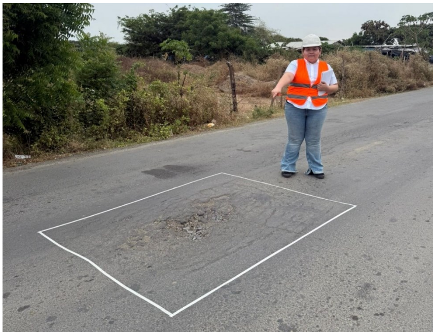
ILUSTRACIÓN 145: INSPECCIÓN VISUAL DE LAS FALLAS PRESENTES EN EL PAVIMENTO
