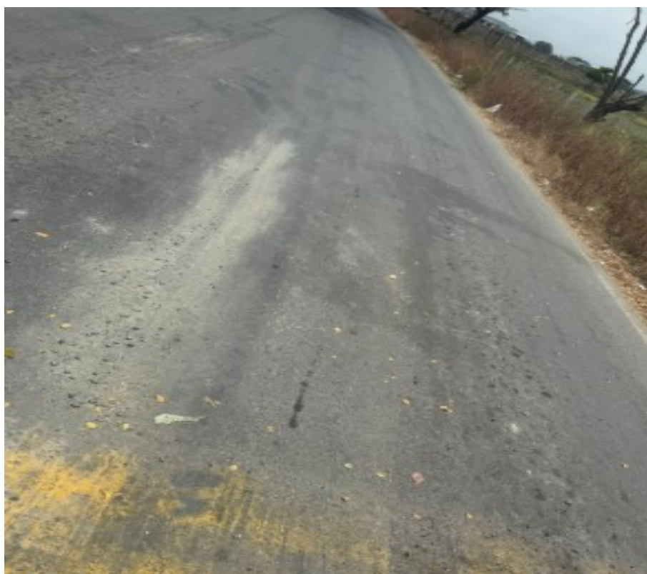
ILUSTRACIÓN 151: FALLA DE DESPRENDIMIENTO DE AGREGADOS EN LA ABSCISA 0+850 Y 0+900
