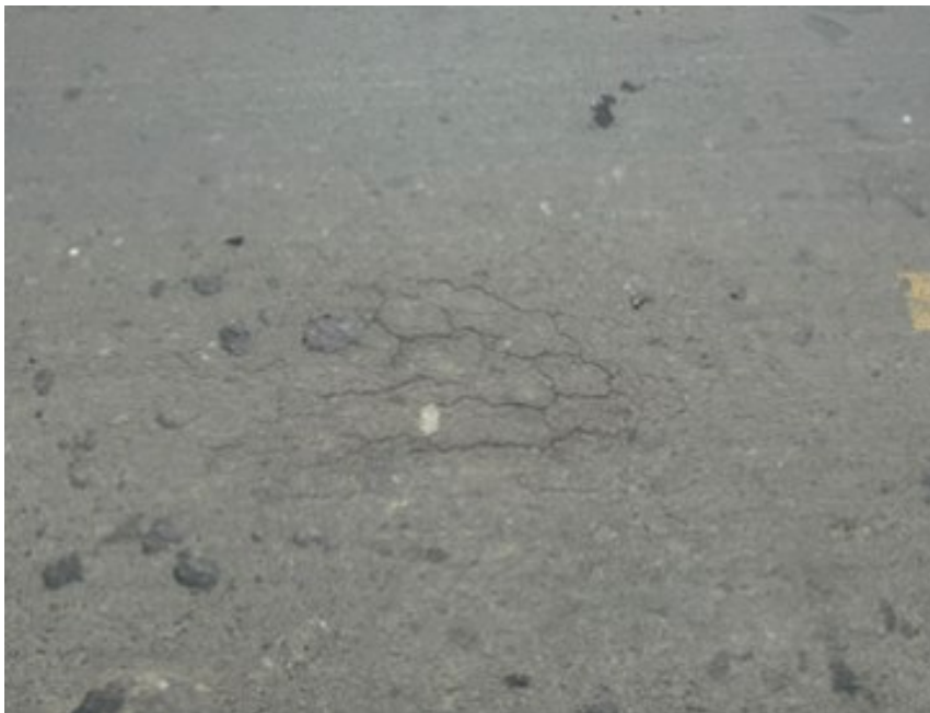
ILUSTRACIÓN 149: FALLA PIEL DE COCODRILO EN LA ABSCISA 0+200 Y 0+250
