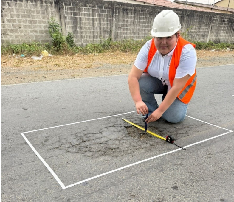
ILUSTRACIÓN 149: FALLA PIEL DE COCODRILO EN LA ABSCISA 0+200 Y 0+250
