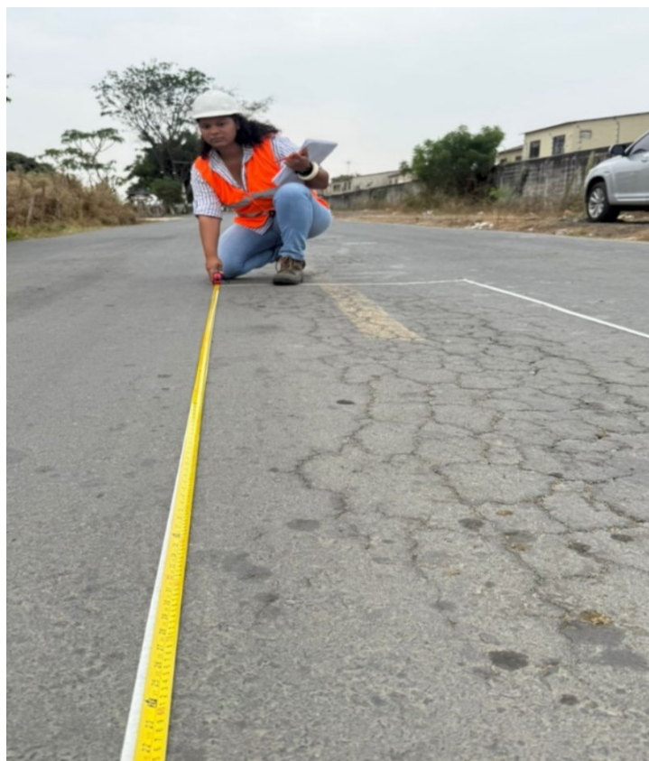
ILUSTRACIÓN 147: MEDICIÓN DEL LARGO DEL ÁREA AFECTADA.
