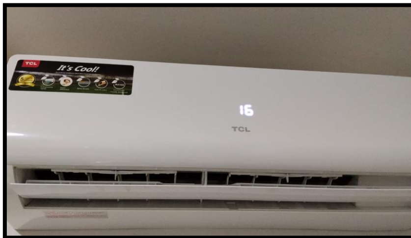
Figura 52 Ajuste automático del aire acondicionado a 16 °C tras la detección de aforo. Fuente: Autores.
