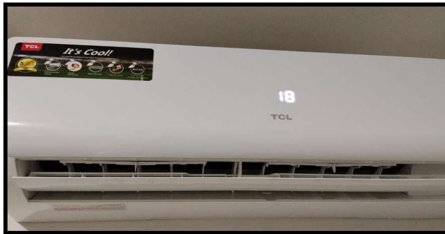
Figura 51 Ajuste automático del aire acondicionado a 18 °C ejecutado por el sistema. Fuente: Autores.
