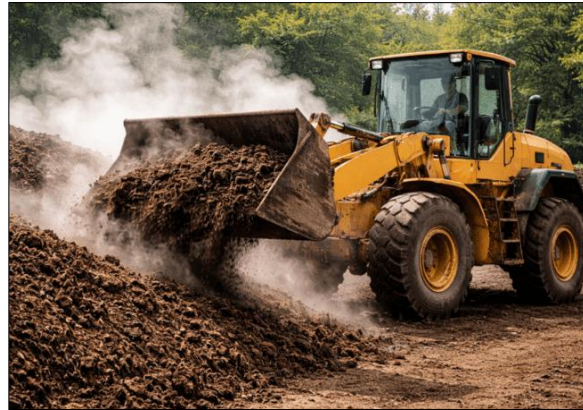
Figura 8. Volteo de compost mediante pala mecánica o cargador frontal.
