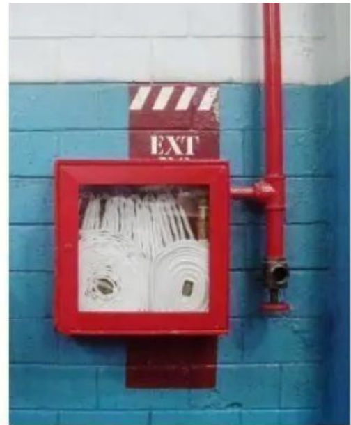
Ilustración 9 - Estación de bombeo del sistema contra incendios y mangueras de control contra incendios
