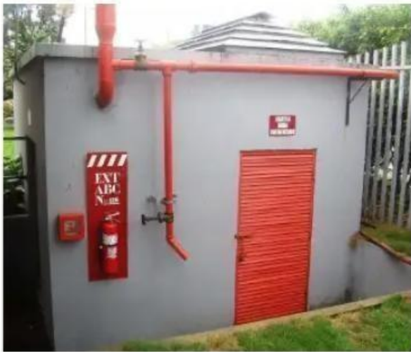
Ilustración 9 - Estación de bombeo del sistema contra incendios y mangueras de control contra incendios
