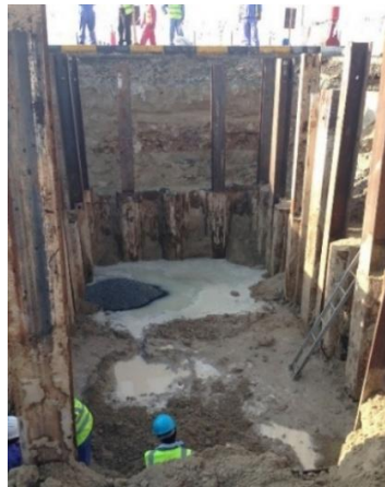
Figura 10 Vista de pilotes mixtos.
