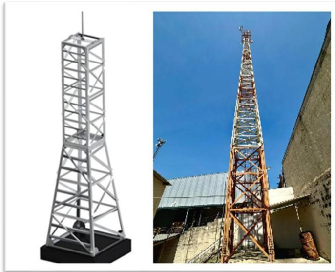
Ilustración 3. Torre autoportante metálica utilizada para telecomunicaciones.
