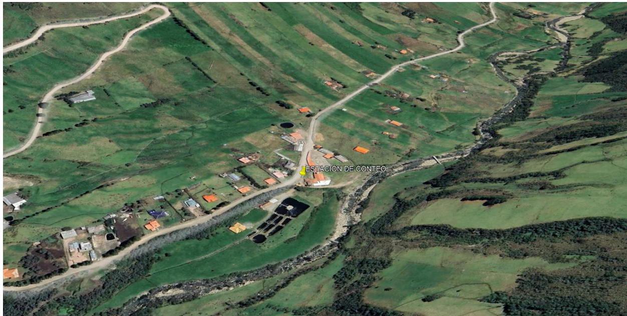
Ilustración 26. Ubicación de la estación de conteo
