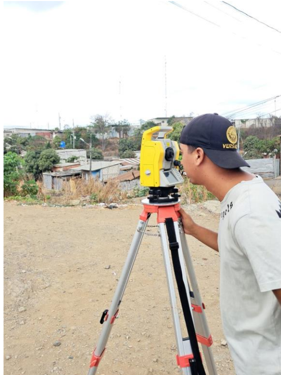
Figura 31. Uso de estación total
