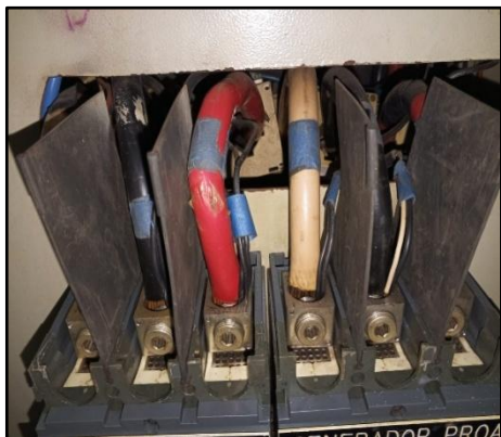
Figura 24. Barraje del Generador.
