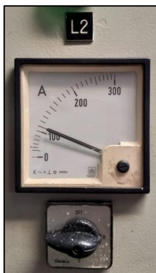
Figura 35. Medición en tiempo real de la Línea L2 de la Carga Total de la embarcación.
