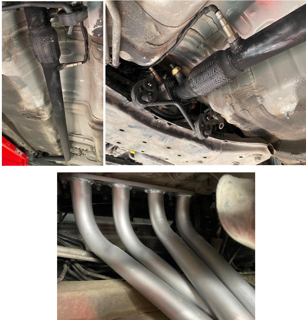
Figura 79. Sistema de escape terminado e instalado
