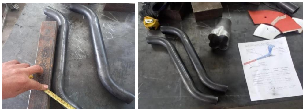
Figura 75. Doblado de tubos según requerimientos
