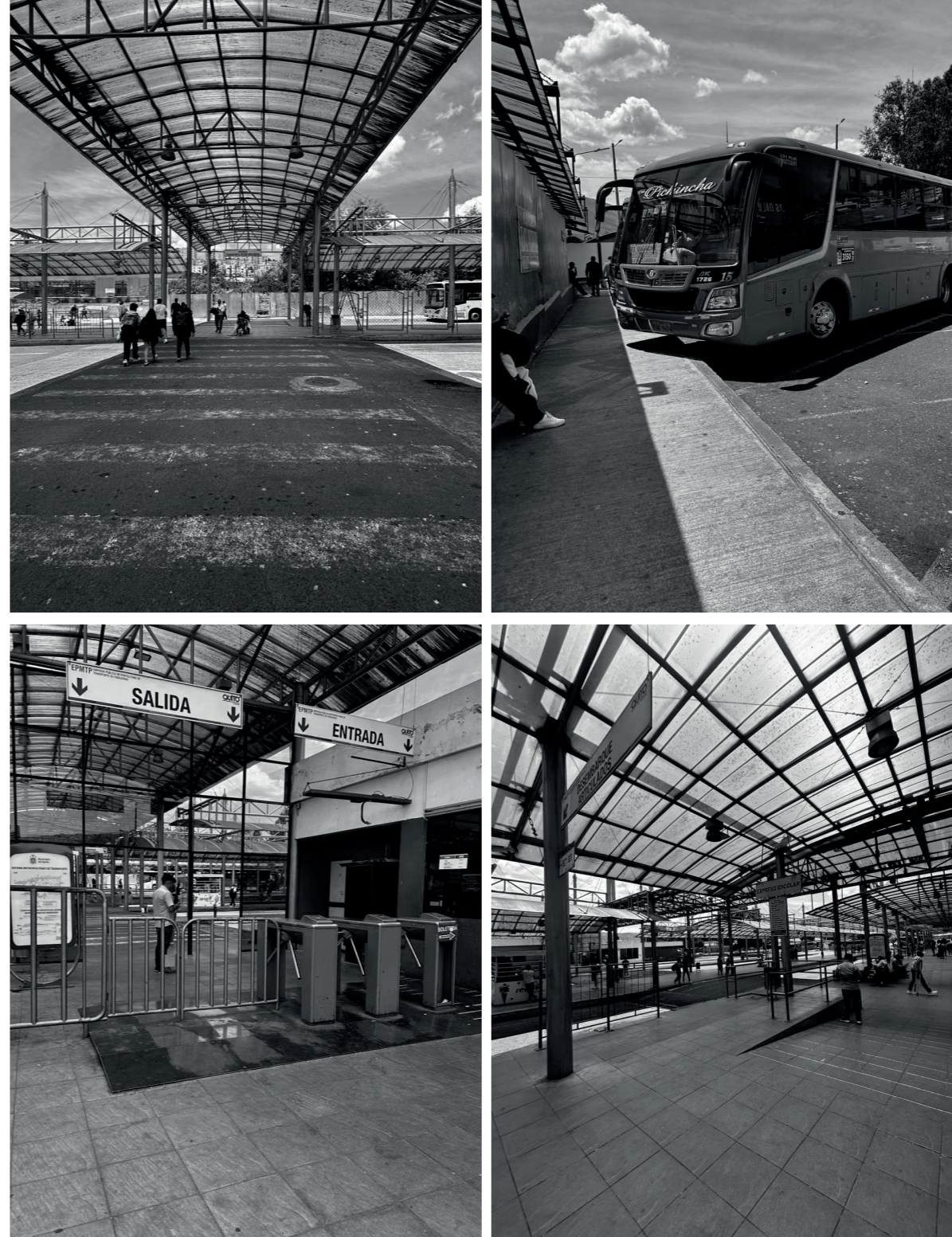
Figura 37. Registro fotográfico del estado actual del Terminal de La Ofelia. (Autor: Paul Cascante, 2025).
