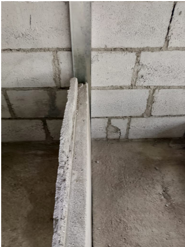
Imagen Colocación de paneles
