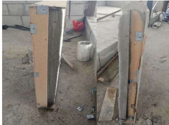
Imagen Paneles Antes de desencofrado.
