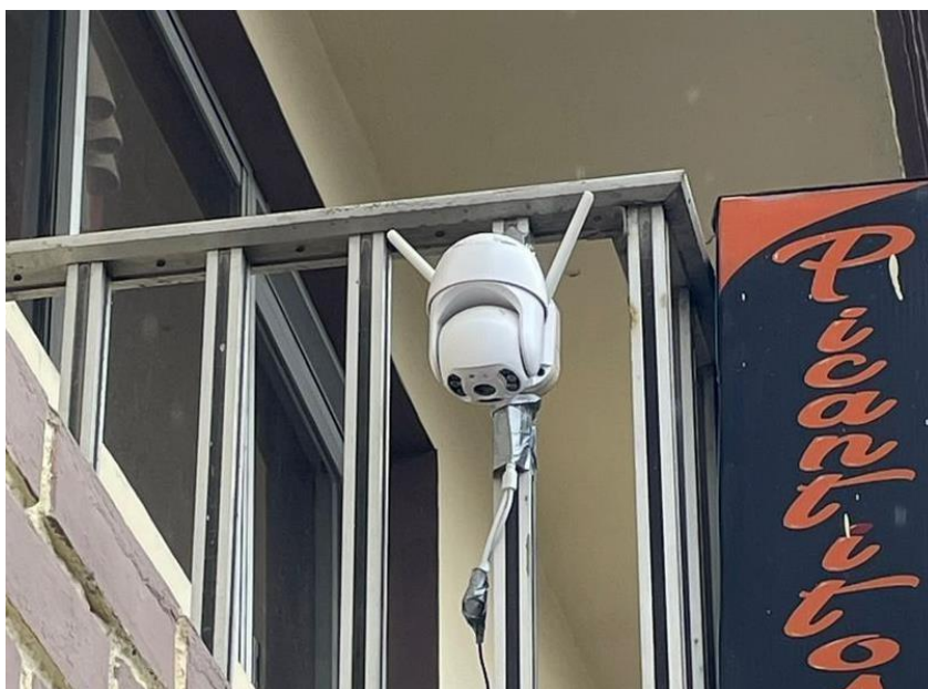
Figura 23. Ubicación de la cámara
