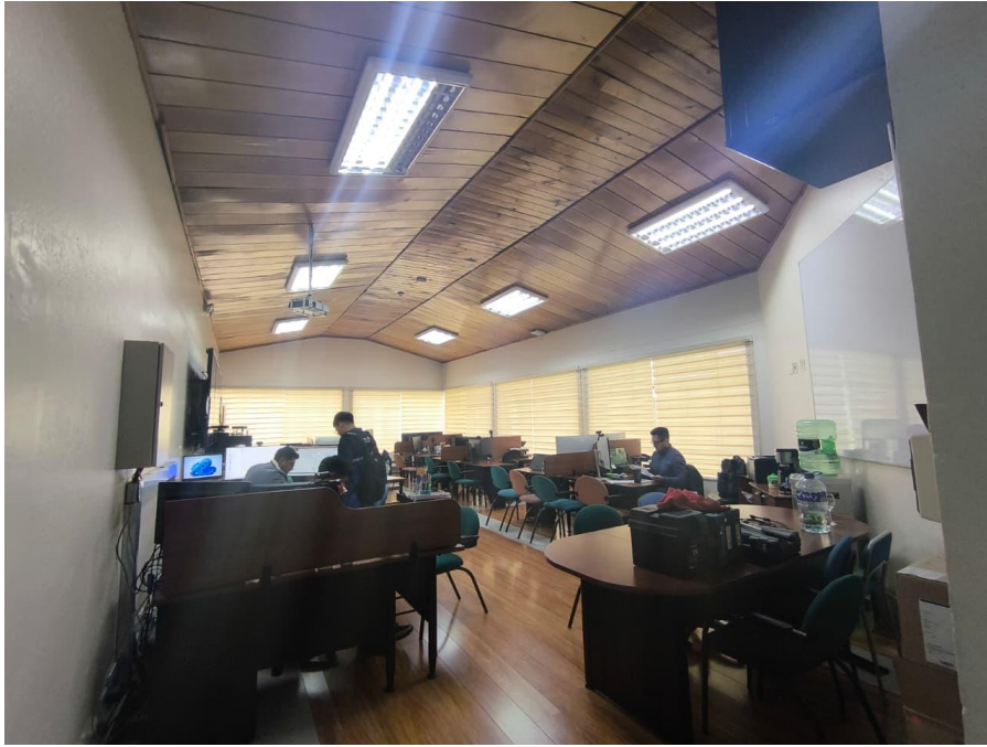
9. AULA CON LUMINARIAS LED 60W
