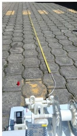
Figura 73. Distancia de 5 metros señalada en el cable.
