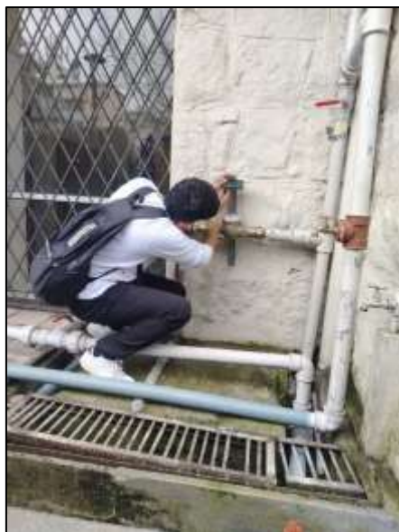
ILUSTRACION 2 COLOCACION DE CAMARAS.
