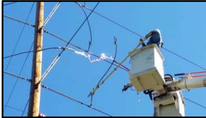
Figura 2.8. Formación de arco eléctrico
