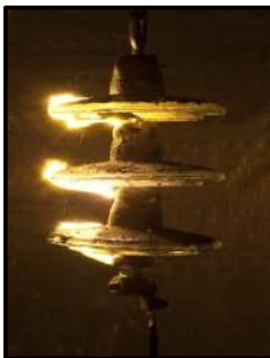
Figura 2.9. Flashover de aislador
