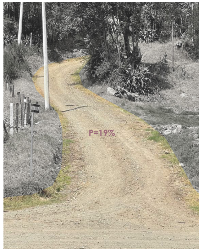
Registro fotográfico de vía lateral
