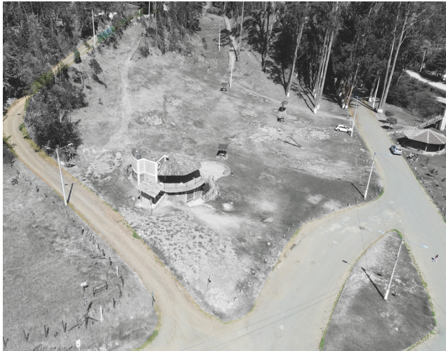
01. Desorganización de vías frontales
