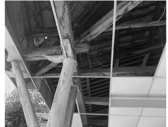
Estado estructural actual
