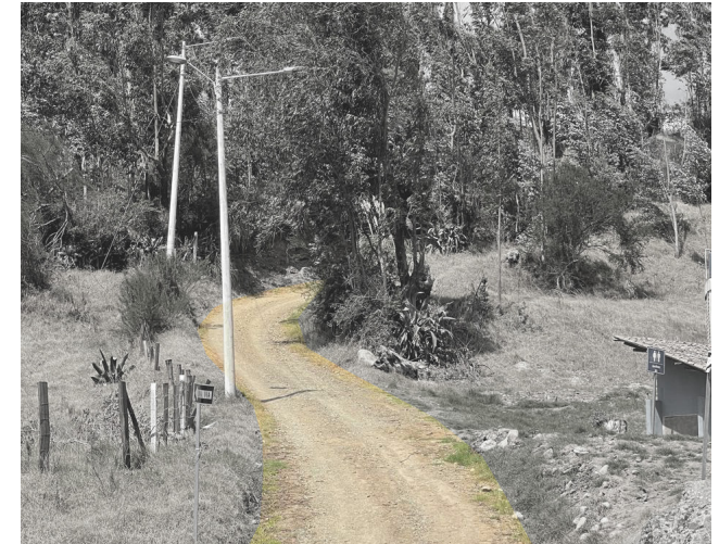
03. Deterioro de vía lateral
