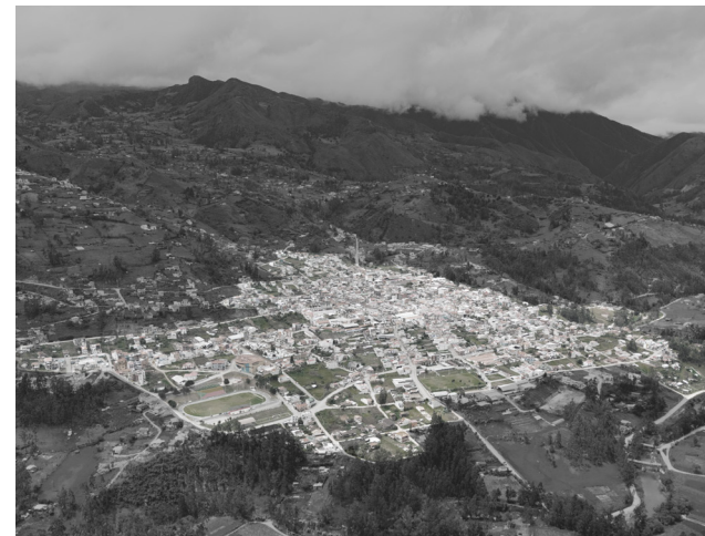
Estado estructural actual de Sigsig
