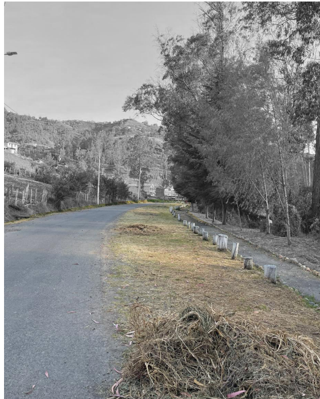
Registro fotográfico de ciclovía actual
