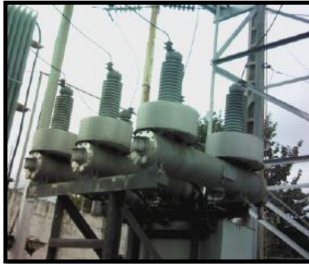
Figura 2. Interrupción de Potencia
