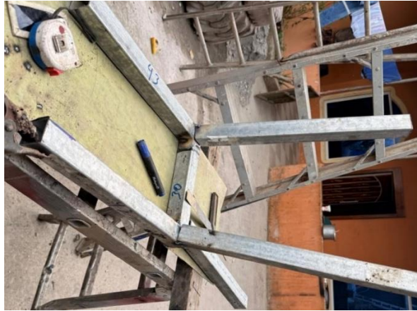
Figura 8. Proceso de soldadura del bastidor del motocultor
