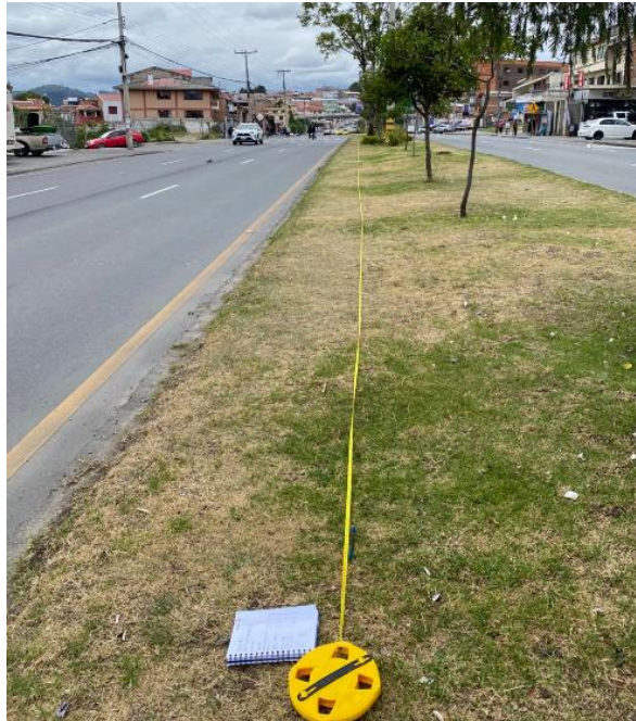
Figura 11. Medición de tramo cada 100m
