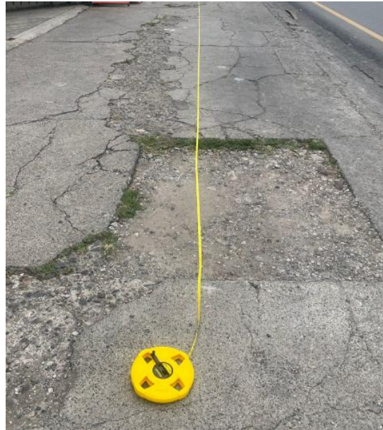
Figura 14. Desgaste de vereda
