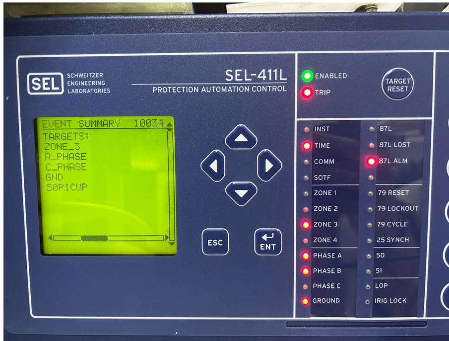
Figura 3.18: Registro HMI del relé SEL-411L ante falla bifásica en la línea 8-7.
