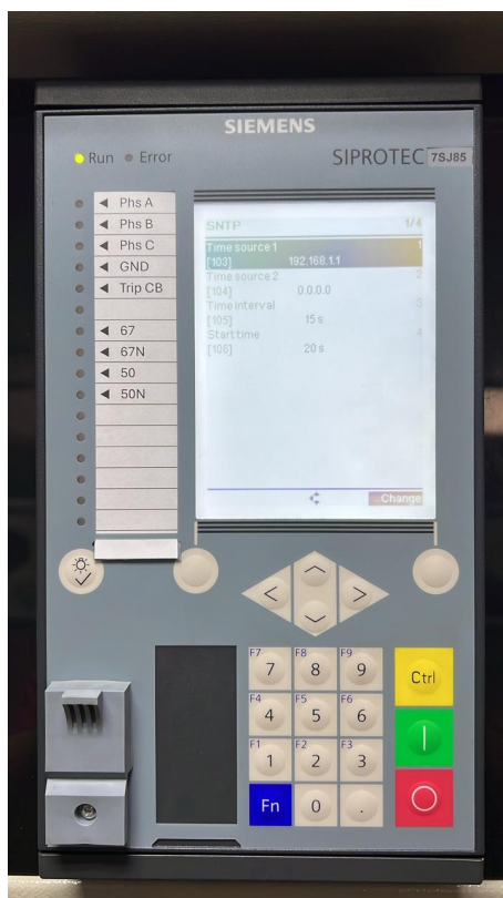
Figura 4.21: Sincronización Sntp de la bahía Catamayo.
