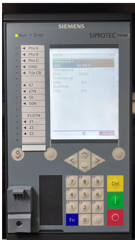
Figura 4.20: Sincronización SNTP de la bahía Velacruz.
