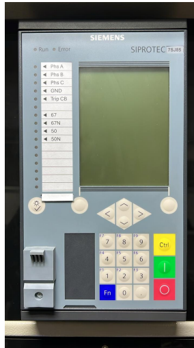
Figura 2.2: Relé de protección Siemens SIPROTEC 7SJ85.
