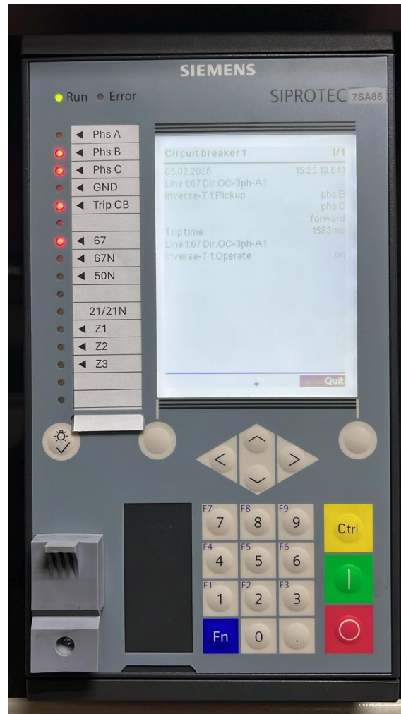
Figura 5.17: Trip del CB de la bahía Equasol.
