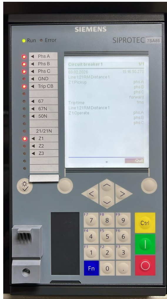
Figura 5.8: Pruebas Z1 Equasol.
