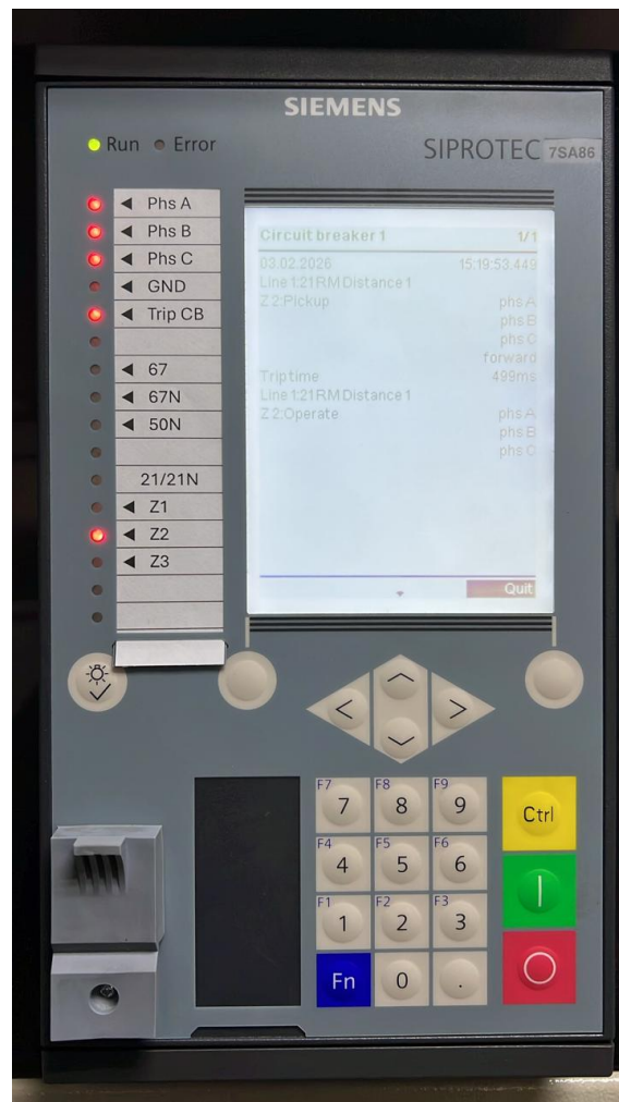
Figura 5.9: Pruebas Z2 Equasol.
