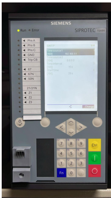
Figura 4.19: Sincronización SNTP de la bahía Equasol.
