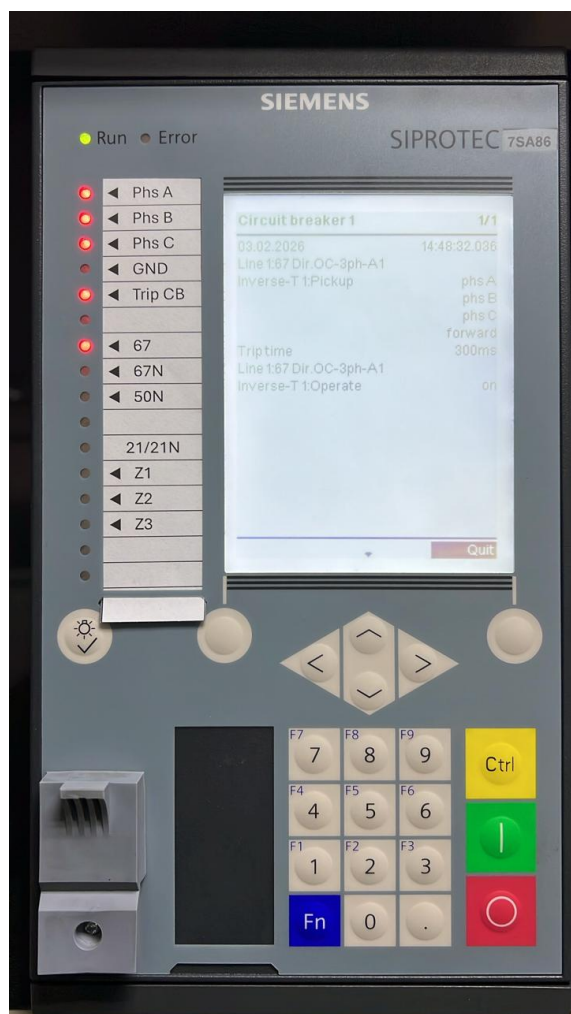
Figura 5.4: Protección de Sobrecorriente Direccional 67 en bahía Equasol.
