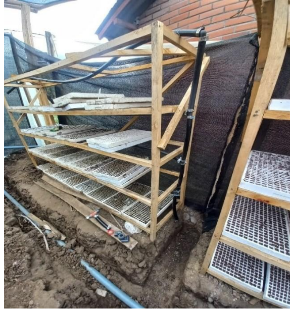
Ilustración 9. Colocación del sistema de riego.
