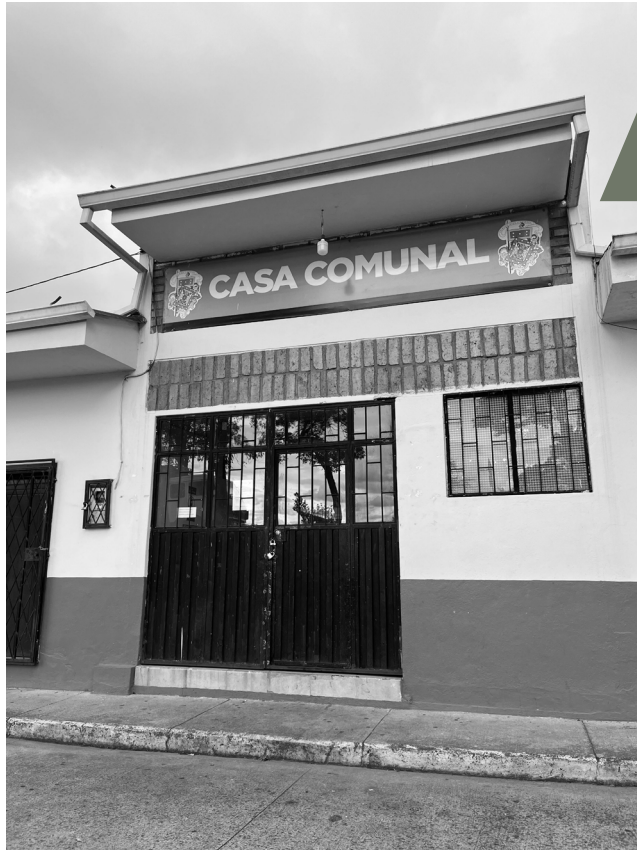
Puerta principal actual Fuente: Elaboración propia
