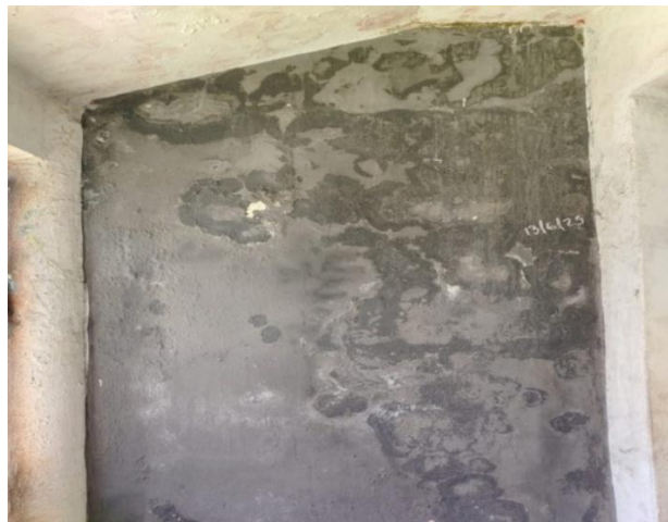
Ilustración 28 Humedad
