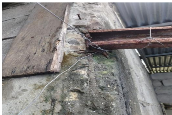
Ilustración 29 Corrosión
