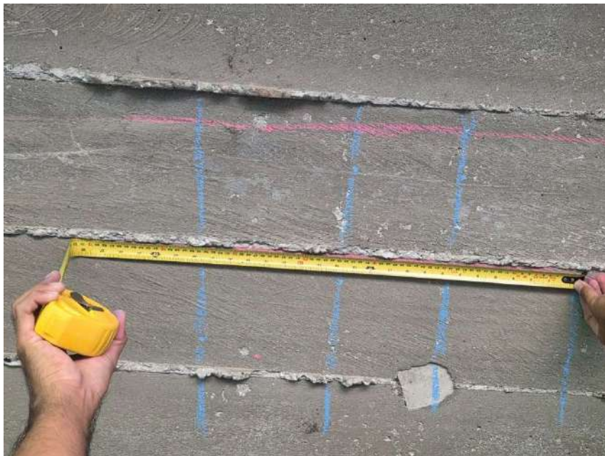
Figura 60: Toma de medidas
