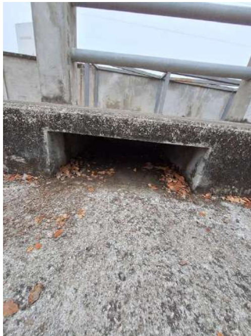
Figura 12: Revisión de estructura de puente
