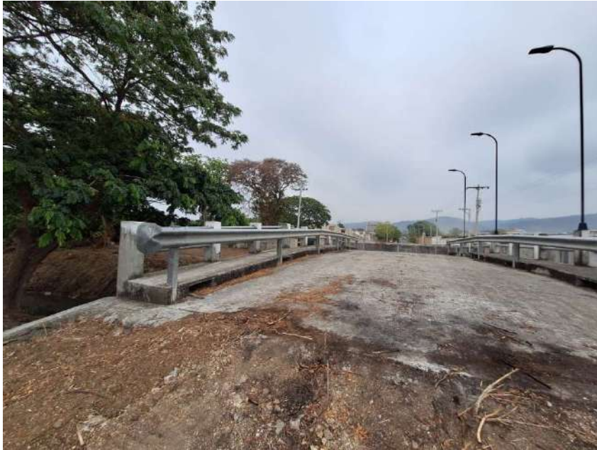
Figura 13: Revisión de estructura de puente
