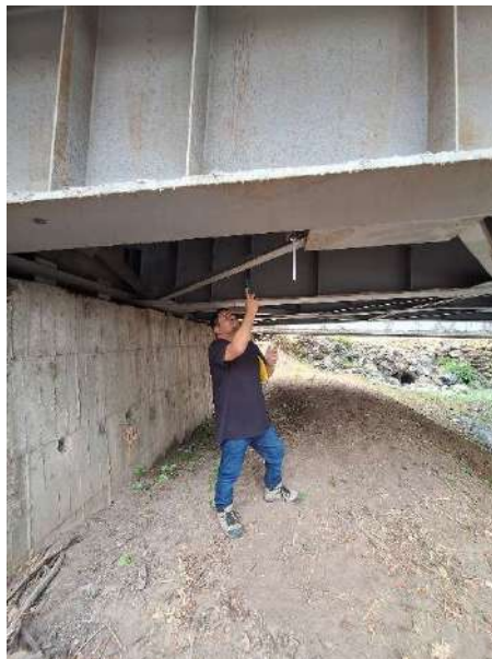
Figura 40: Inspección visual de viga de puente
