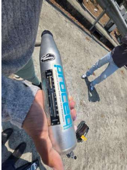
Figura 41: Ensayo de esclerometría
