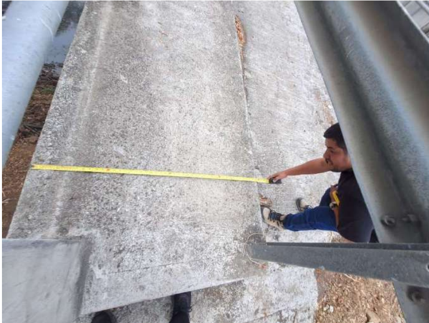
Figura 23: Relevamiento de elementos de puente
