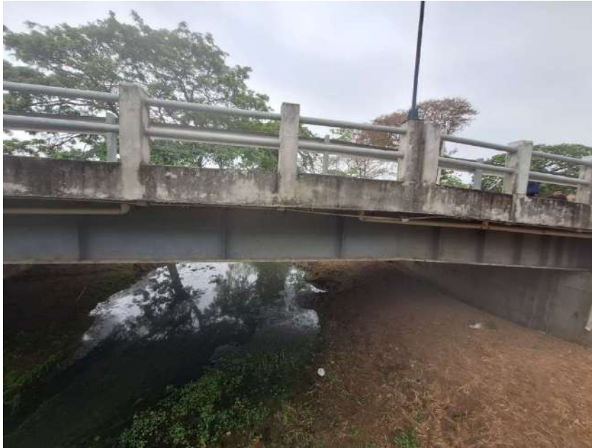
Figura 31: Revisión estructural de viga
