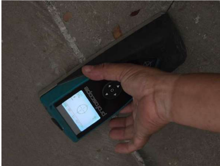
Figura 63: Toma de datos de ensayo de pachometría
