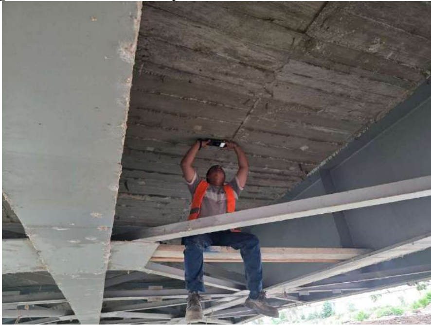
Figura 69: Toma de datos en puente
