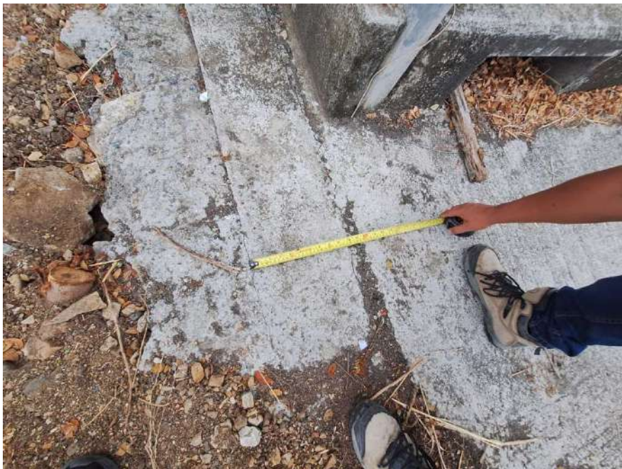
Figura 26: Medición de elementos de puente
