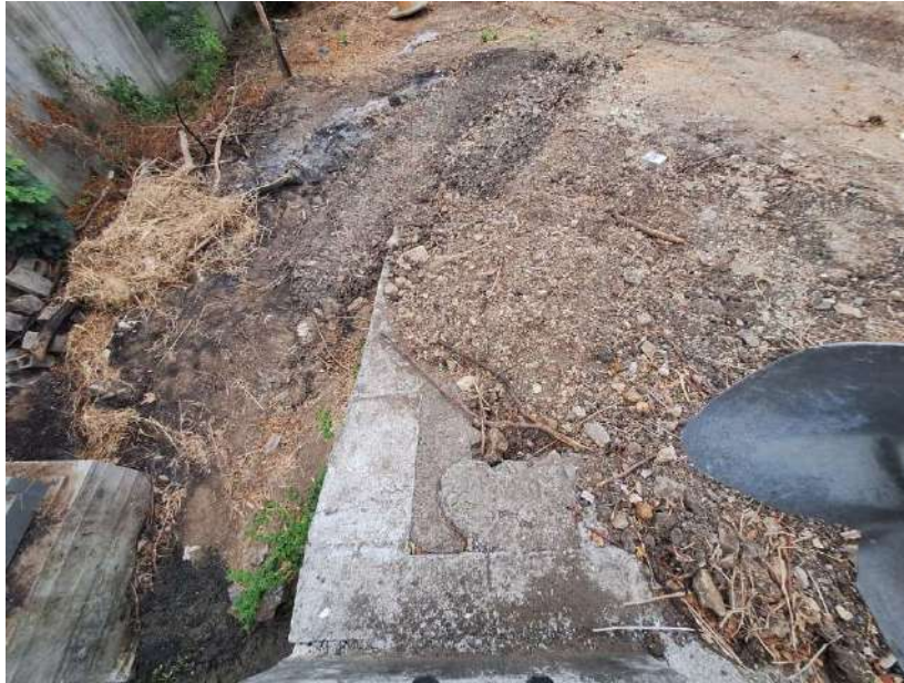
Figura 15: Reconocimiento visual de cimentación
