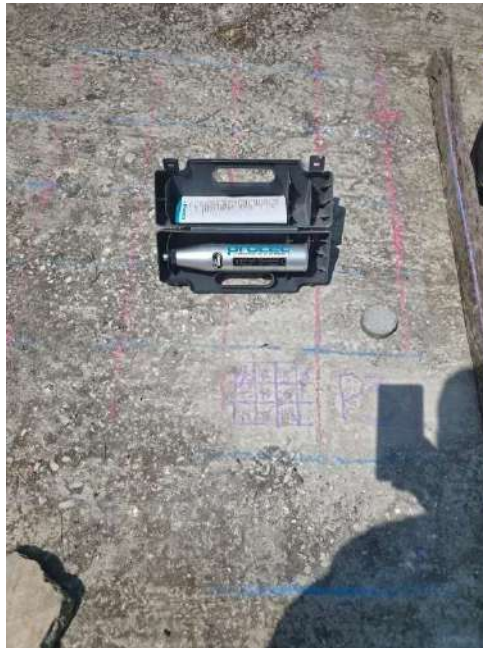
Figura 44: Toma de datos de ensayo de esclerometría
