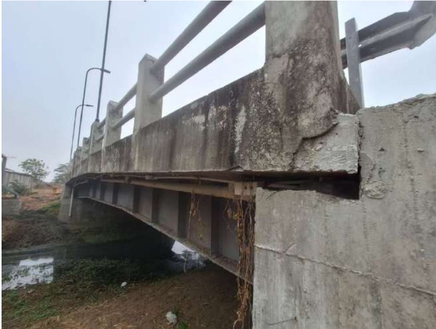
Figura 29: Revisión de elementos estructurales
