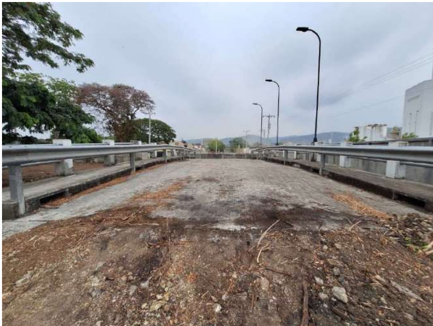
Figura 14: Revisión visual de estructura del puente
