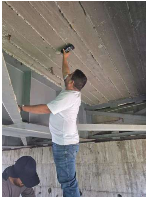
Figura 61: Toma de datos por el tesista
