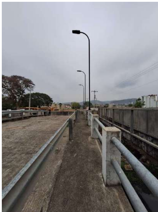
Figura 16: Revisión de estructura
