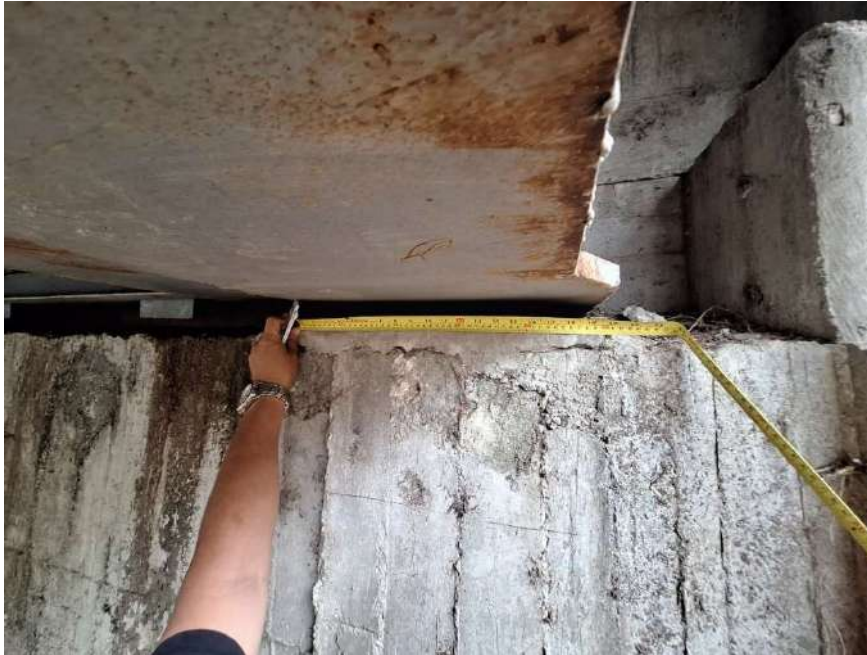
Figura 37: Toma de medidas de elementos
