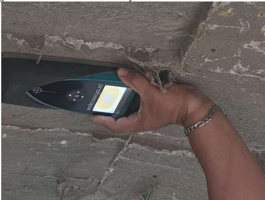
Figura 66: Toma de lectura de ensayo
