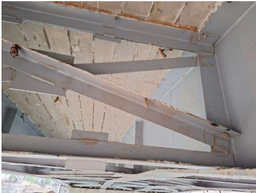
Figura 32: Inspección visual de viga de puente
