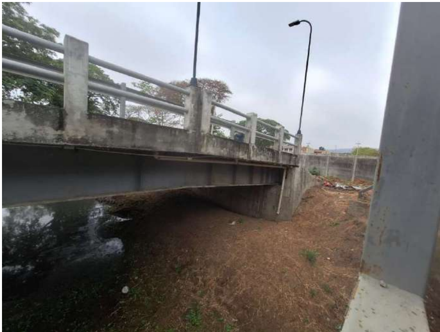
Figura 30: Revisión visual de viga
