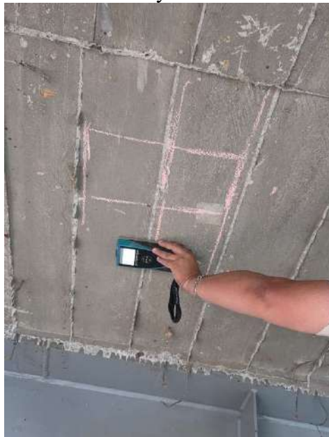
Figura 72: Toma de lectura de ensayo
