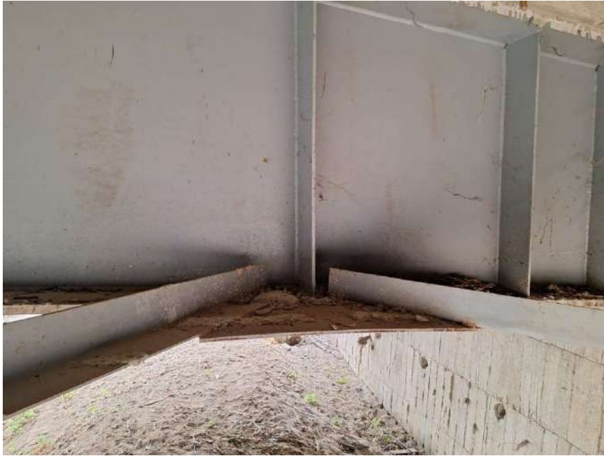
Figura 33: Inspección visual de viga de puente
