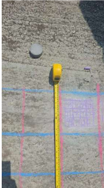
Figura 49: Toma de medidas para ensayo
