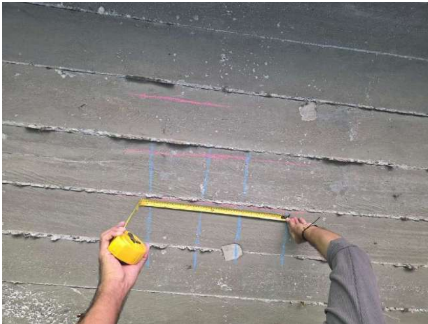
Figura 58: Toma de datos por debajo de puente
