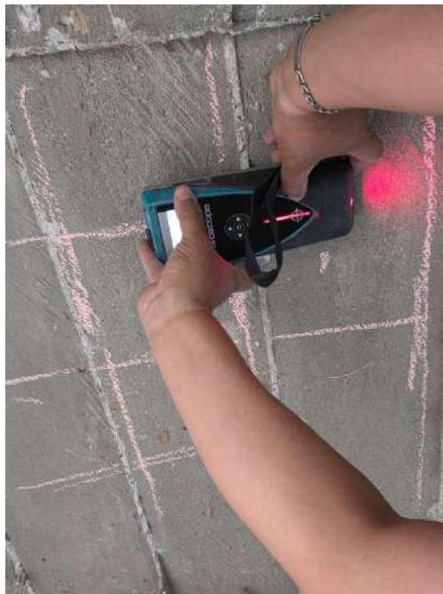
Figura 70: Toma de datos por el tesista
