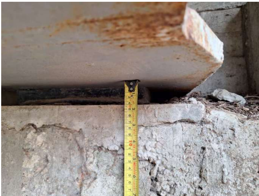
Figura 36: Medición de elementos estructurales
