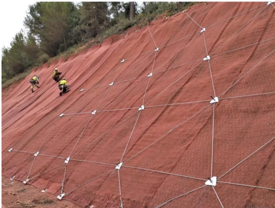
Figura 23 Uso de mallas metálicas en taludes
