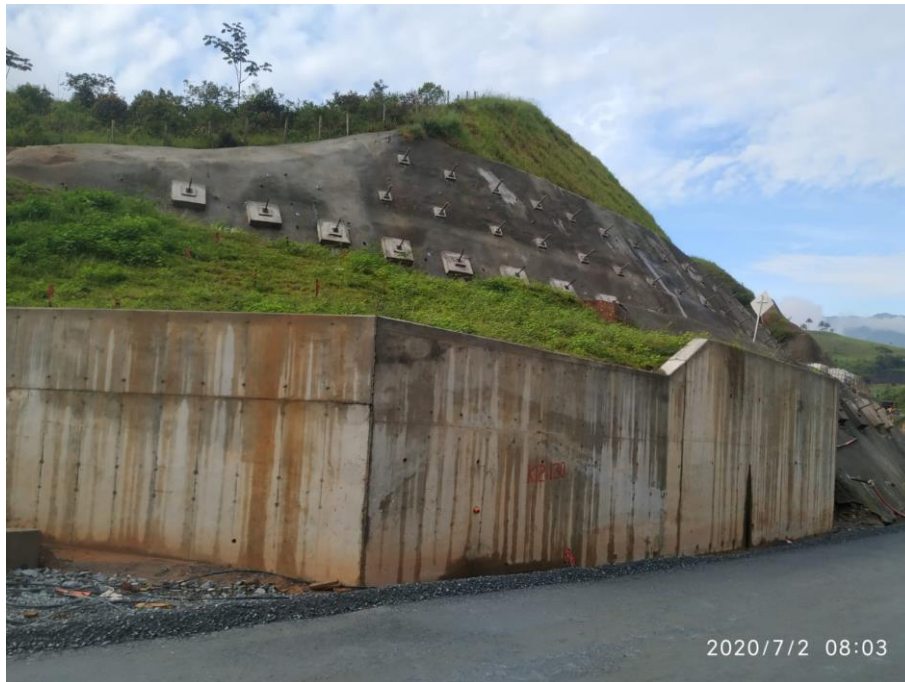
Figura 32 Muro de contención aplicado en estabilización de taludes
