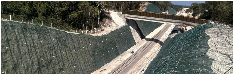
Figura 25 Aplicación de malla de acero de doble torsión para la protección de taludes
