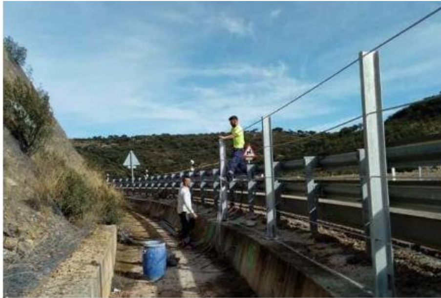
Figura 34 Instalación de barrera dinámica para estabilización de taludes
