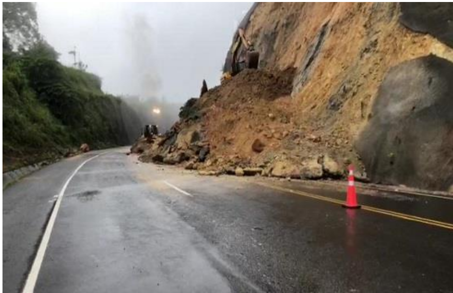
Figura 16 Derrumbes en taludes en carretera
