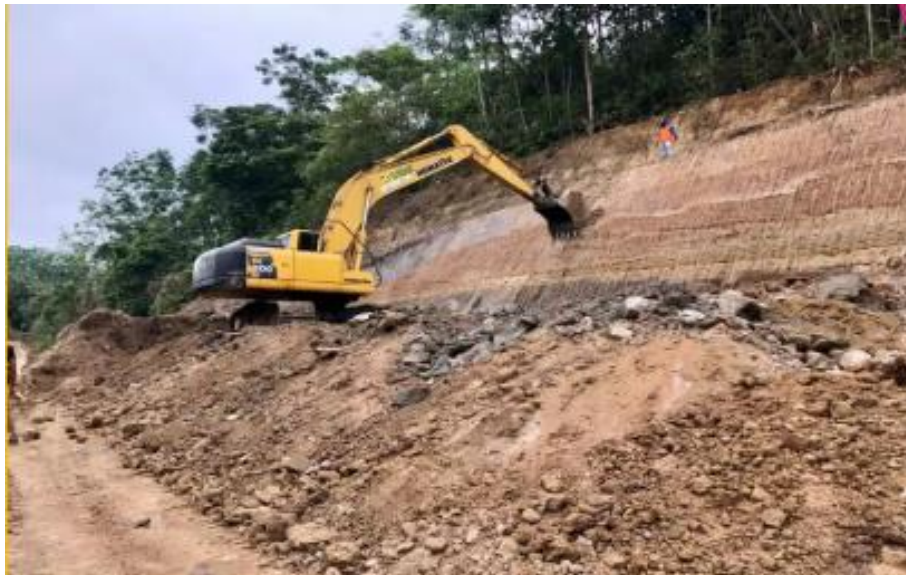
Figura 22 Control de materiales inestables en un talud
