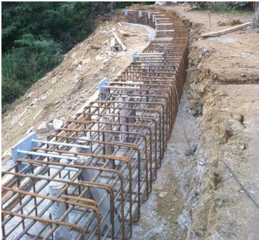
Figura 28 Estabilización de talud mediante micropilotes
