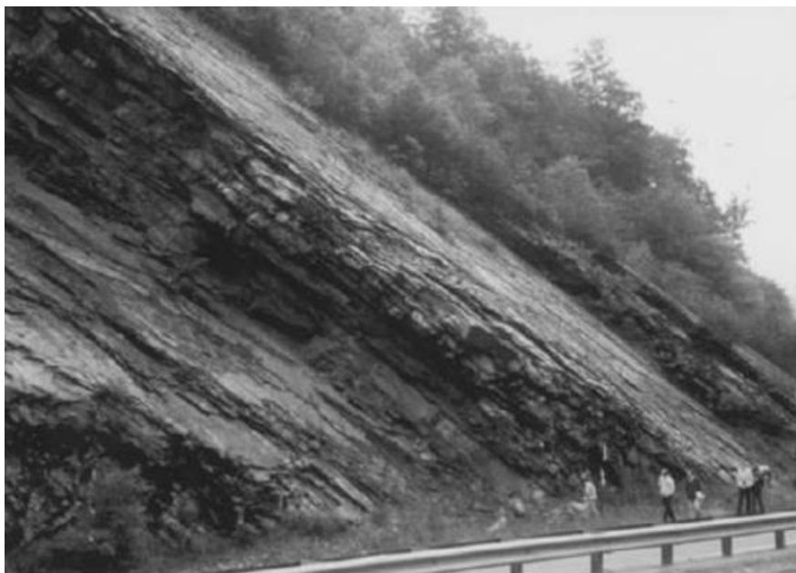
Figura 14 Falla por deslizamiento superficial en taludes naturales
