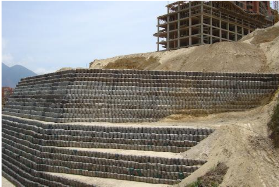
Figura 21 Construcción de bermas o bancos para la estabilización de un talud
