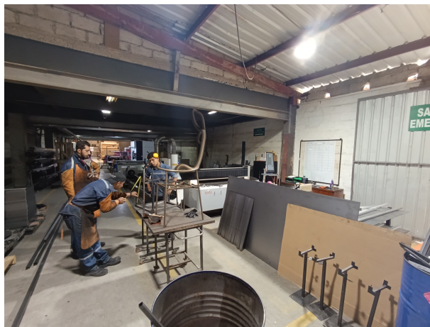
Figura 19. Estación de trabajo de corte láser CNC en el cual se encuentran 3 operarios realizando inspección visual y dimensional de los perfiles metálicos posteriores al corte. Esta actividad es fundamental para asegurar que las piezas cumplan con las especificaciones establecidas en la (O.P.)
