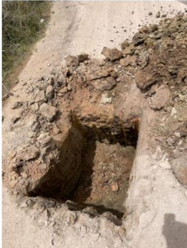
Figura 46 Excavación Calicata
