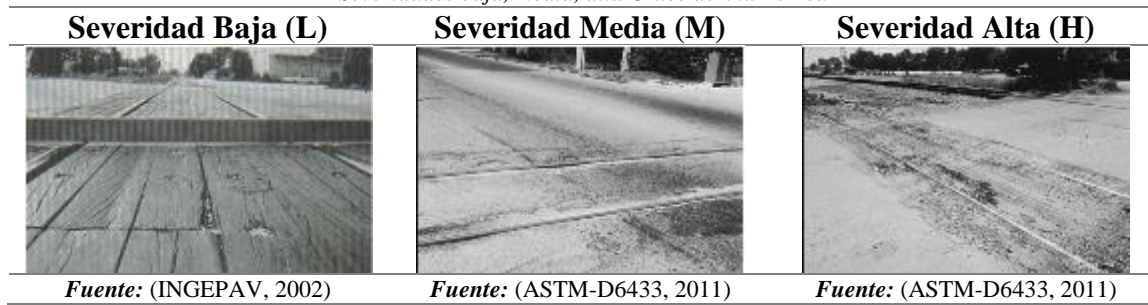
Ilustración 20 Severidades baja, media, alta Cruce de Vía Férrea
