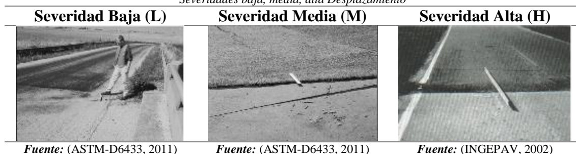
Ilustración 22 Severidades baja, media, alta Desplazamiento
