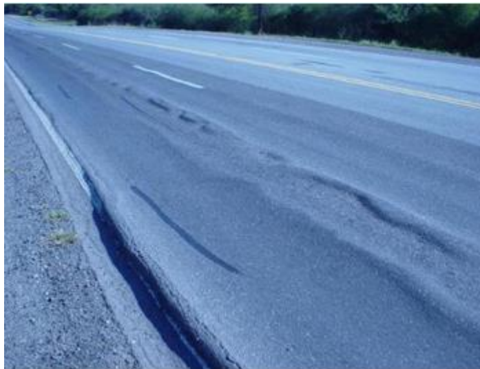
Figura 3. Ahuellamiento
