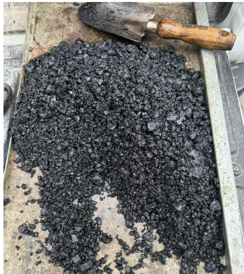
Figura 34. Homogeneización de la mezcla asfáltica con incorporación de RAP
