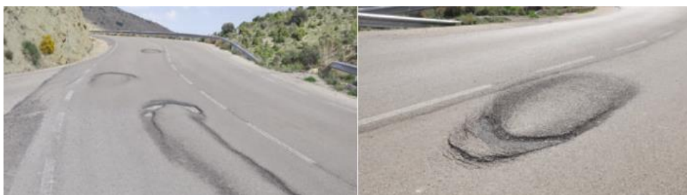
Figura 4. Hundimiento
