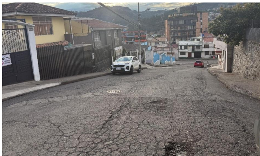
Figura 16. Estado actual de la vía (Tramo final)
