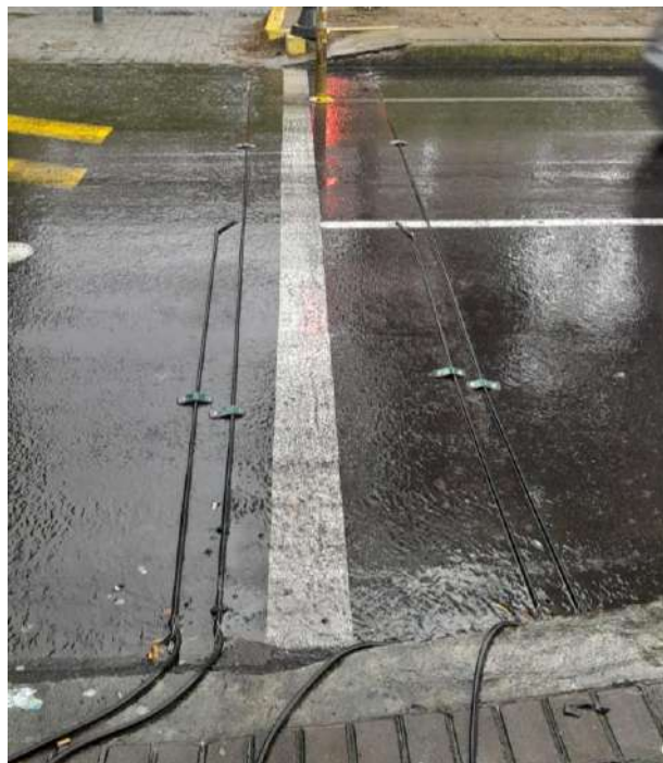
Ilustración 15: Instalación tubos neumáticos. Elaborador por:Autores
