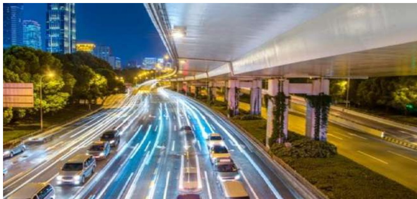
Ilustración 6: Infraestructura vial, Imagen obtenida de: https://www.pucesa.edu.ec/infraestructura-vial-en-ecuador/
