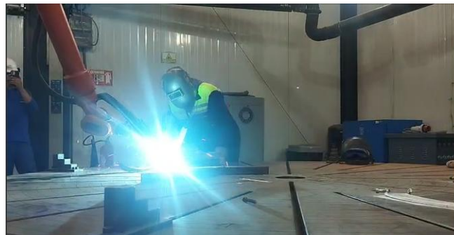
Figura. 86 Proceso de soldadura en superficie curva
