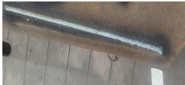
Figura. 78 Cordón de soldadura
