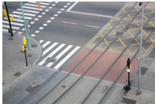
Figura 13 Delimitación con cruce peatonal y cruce de vehículos.
