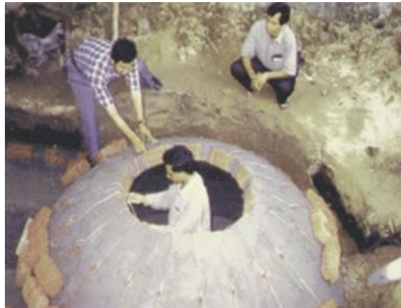
Figura 8. Biodigestor cúpula fija en construcción
