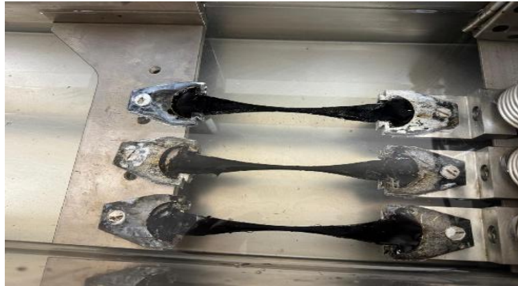
Figura 22. Ensayo de Ductilidad (Inicio del Ensayo)
