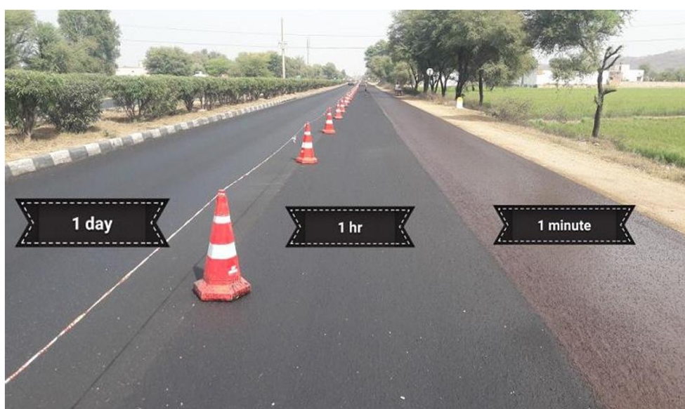
Ilustración 14. Tramo Mahua-Jaipur de la Carretera Nacional NH-21 - India.
