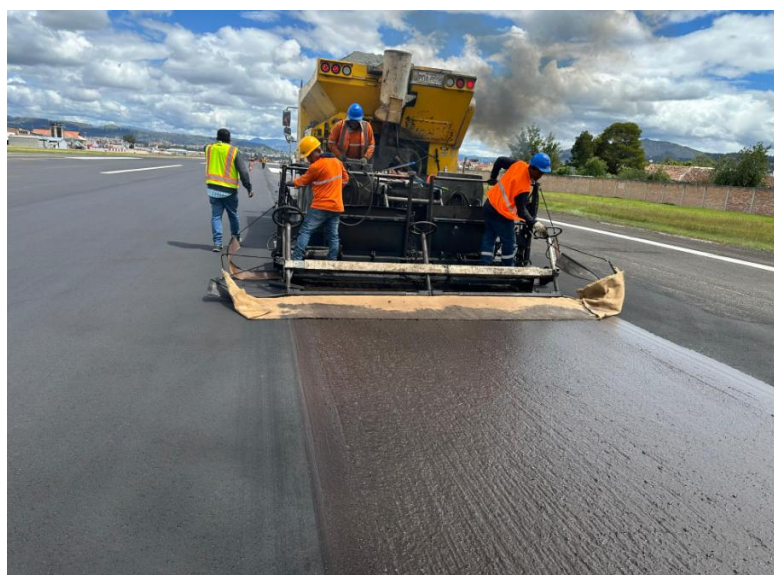
Ilustración 13. Colocación de Micropavimento Aeropuerto La Mar Cuenca, 2025.
