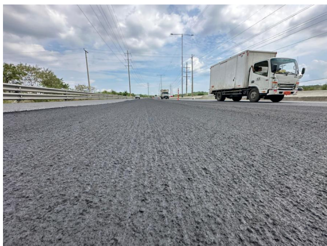
Ilustración 2. Micropavimento tipo III, Vía Perimetral Guayaquil 2024.
