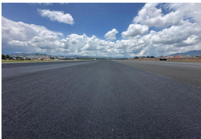
Ilustración 1. Micropavimento tipo II, Aeropuerto La Mar Cuenca 2025.
