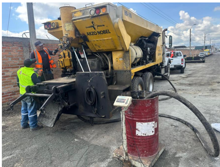
Ilustración 12. Calibración de Equipo para micropavimento.
