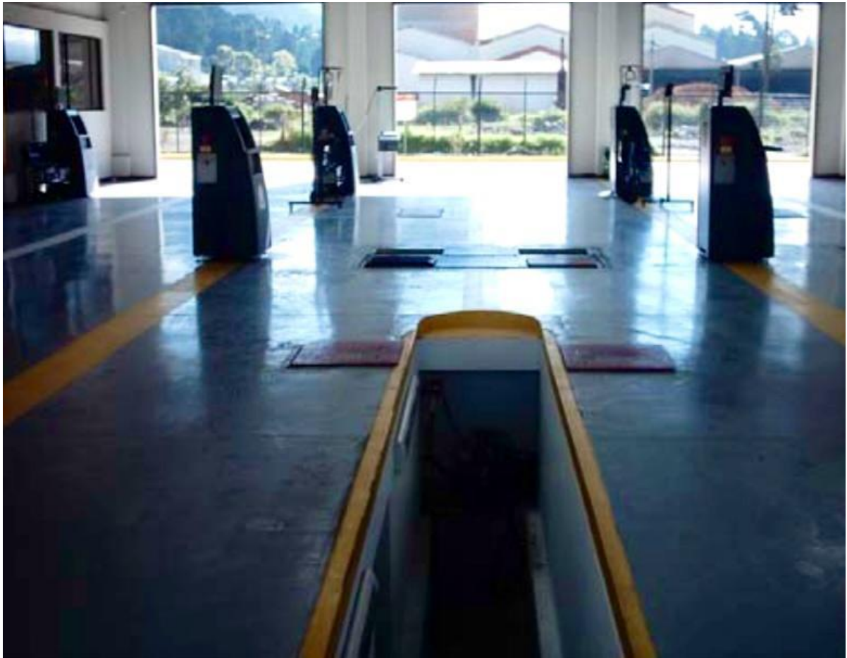
Ilustración 13:Fosa de inspección y detector de holguras.
