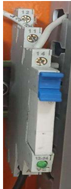
Relé electromecánico para sensor inductivo
