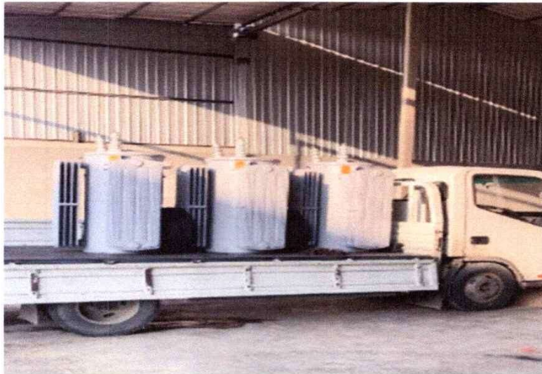
Figura 2.5. Transporte de transformadores
