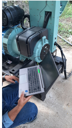
Figura 3.6: Verificación del Generador instalado
