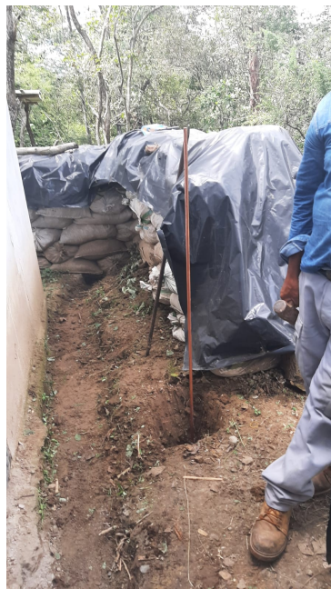
Figura 3.3: Preparación del terreno para la puesta a tierra
