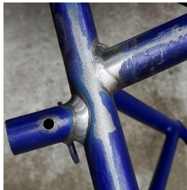
Figura 104.- Resultados Inspección Visual – Zona de Dirección
