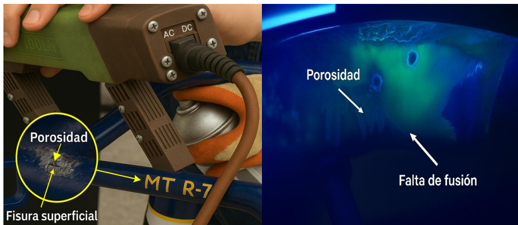
Figura 52.- Inspección con yugo magnético en la junta A-7 (inferior)
