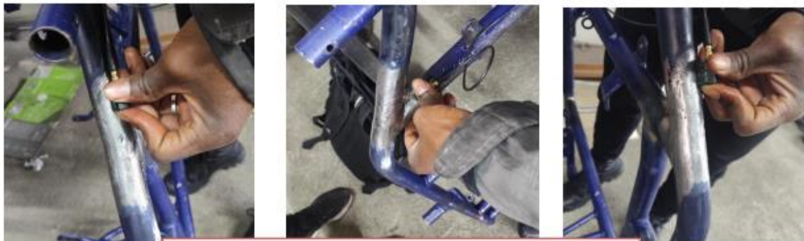
INSPECCIÓN EN JUNTAS SOLDADAS MEDIANTE ULTRASONIDO
