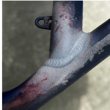
Figura 119.- Inspección de tinta coloreada
