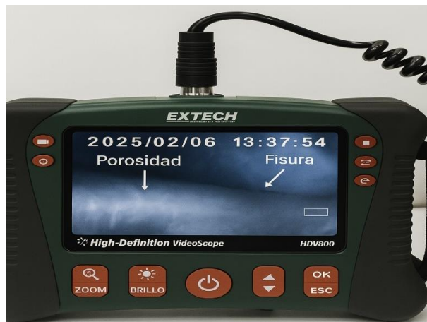
Figura 102.- Identificación de defectos internos mediante análisis visual
