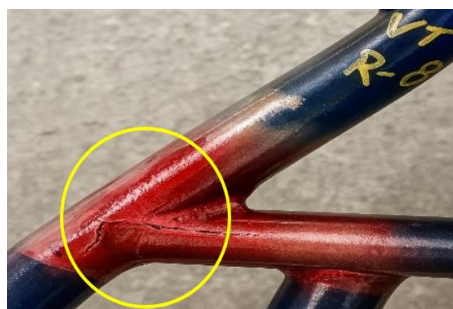
Figura 42.- Junta A-8 (inferior) con porosidad y falta de fusión evidenciada (VT-R)
