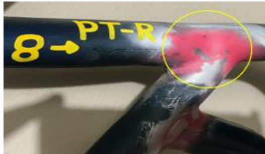
Figura 122.- Detección de defectos superficiales en soldadura
