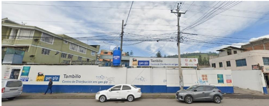
Figura 1. Centro de Distribución de Gas - Tambillo Fuente: Google Maps [1]
